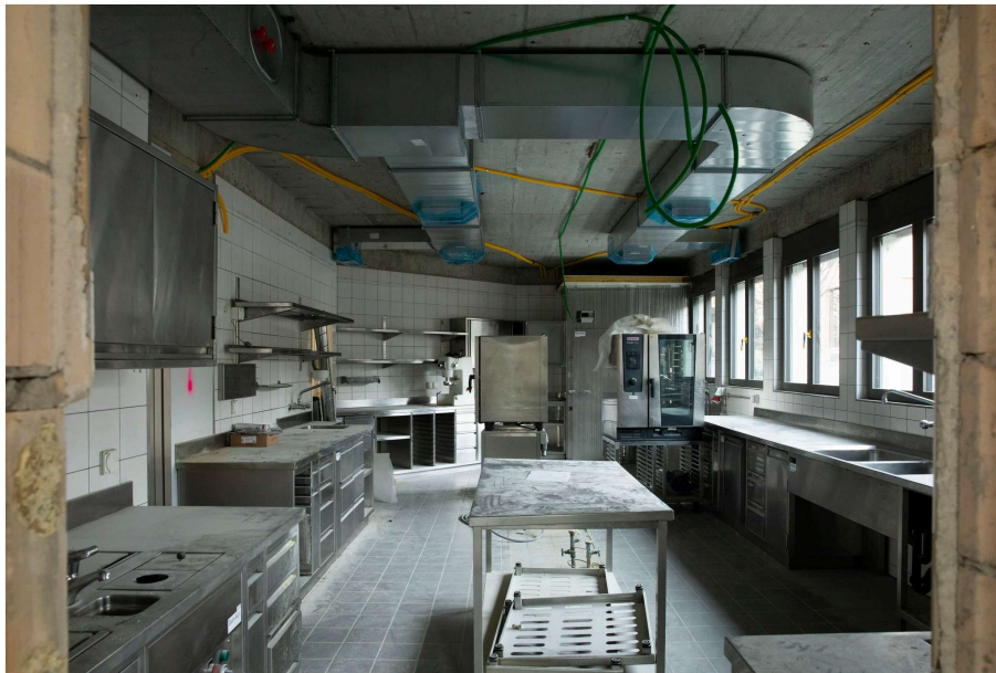
Der «Degen» im Umbau. Bild: Jakob Ineichen (Hünenberg, 10. 2. 2026)
